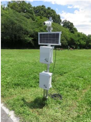
撮影・計測システム設置
