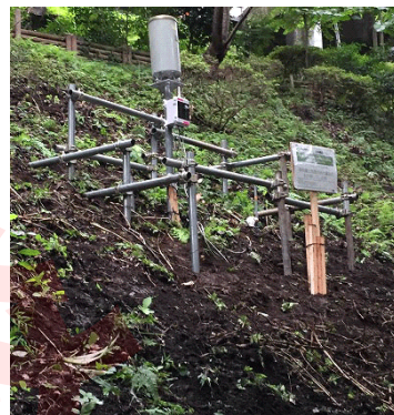
写真1 斜面のWeb観測システム
